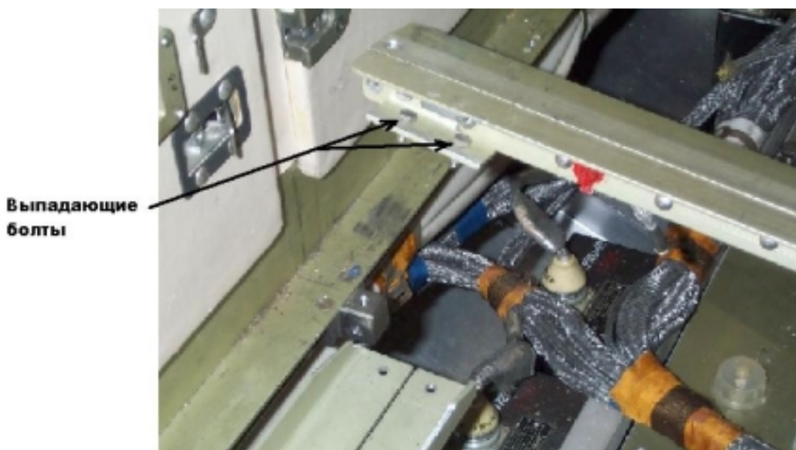
Рис.12.1-2. . Поперечный профиль, снимаемый при демонтаже бл А73, крупным планом. (гайки уже отвинчены)
